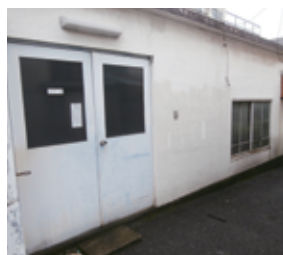
更新前設備 (A重油ボイラ室建物)
